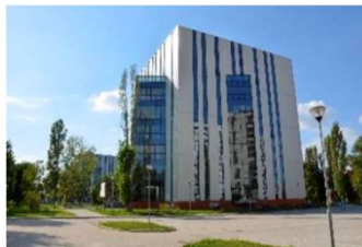
Clădirea PRECIS a Facultății de Automatică și Calculatoare
